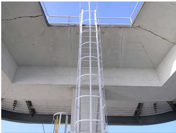
Obrázek 3c: Trhliny v podhledu čelní části
