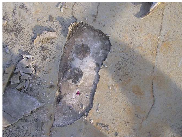
Obrázek 6a: Rozsáhlé poškození izolačního souvrství
