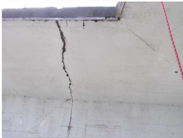
Obrázek 4c: Detail trhliny v levé části
