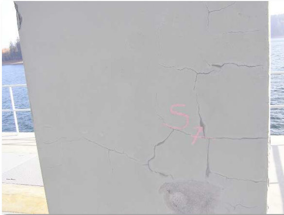
Obrázek 1b: Trhlinky ve vyrovnávací stěrce sloupu 1
