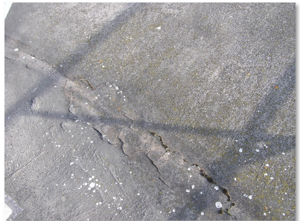
Obrázek 10c: Detail poškození izolační stěrky
