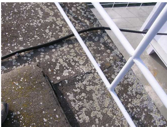
Obrázek 11c: Oddělování stěrky od podkladu
