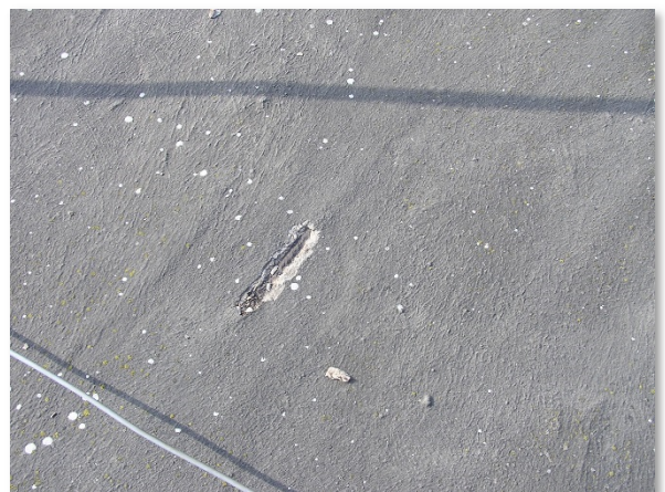
Obrázek 12c: Korodující výztuž bez krytí
