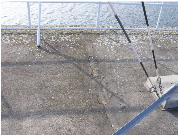
Obrázek 9c: Poškození stěrky nad trhlinou
