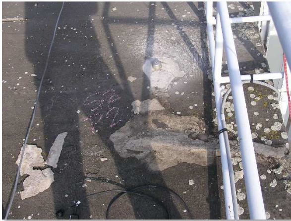
Obrázek 7c: Oddělení stěrky od podkladu
