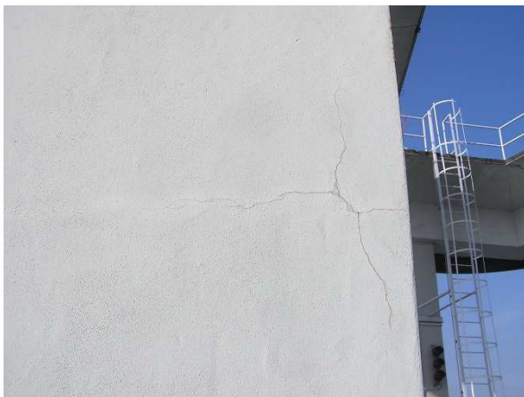
Obrázek 3b: Trhlinky na sloupu 4
