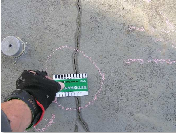
Obrázek 9a: Trhlina v izolačním souvrství
