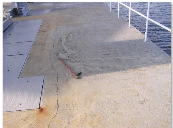
Obrázek 2a: Trhlina s odděleným podkladem
