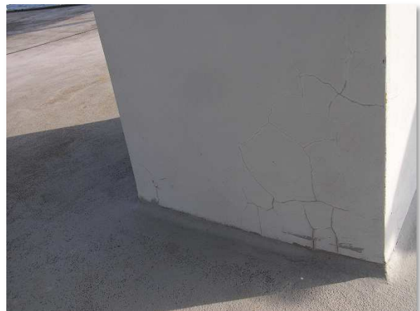
Obrázek 4b: Trhlinky ve vyrovnávací stěrce sloupu 4 u podlahy
