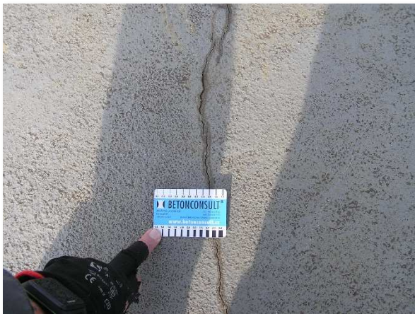
Obrázek 11a: Drobná trhlina v izolačním souvrství
