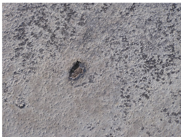
Obrázek 3a: Lokální poškození izolace
