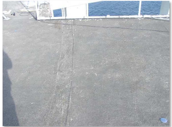
Obrázek 8c: Opravovaný povrch nad dilatací
