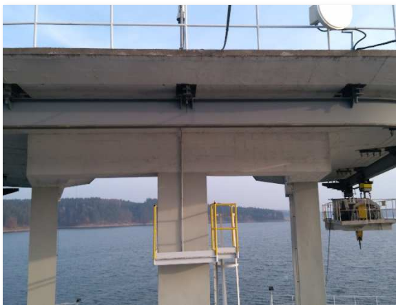
Obrázek 1c: Pohled na průvlak a desku jeřábové dráhy
