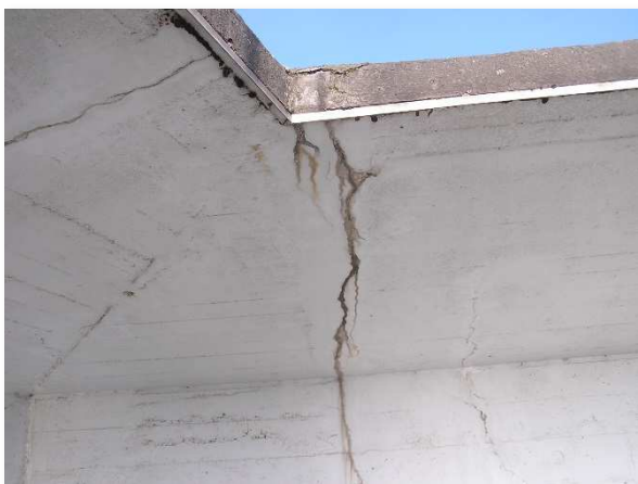
Obrázek 5c: Detail trhliny v pravé části
