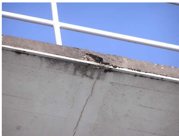
Obrázek 6c: Poškození v čele desky
