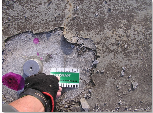
Obrázek 10a: Drobná trhlina ve vyrovnávací stěrce
