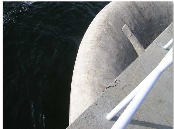
Obrázek 12a: Oddělování betonu ve svislé části desky
